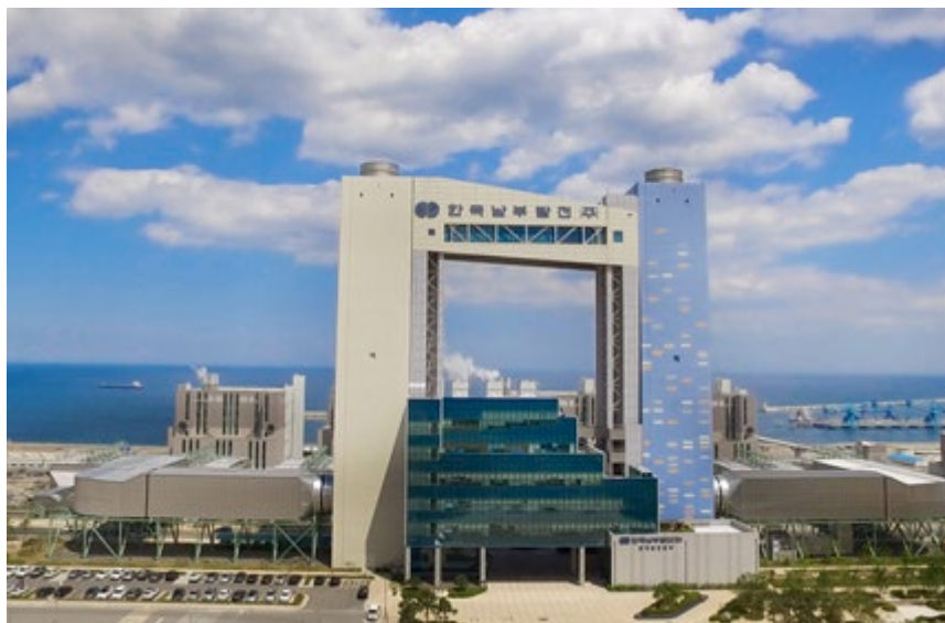
Samcheok Thermal Power Site
